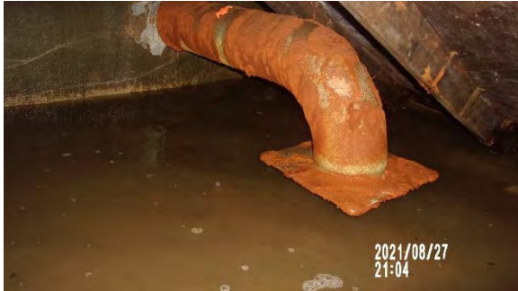
ภาพอุปกรณ์ภายในบ่อ Fire Tank 3 สนิมขึ้นแต่ไม่มีการชำรุดเสียหาย ใช้งานได้ตามปกติ
