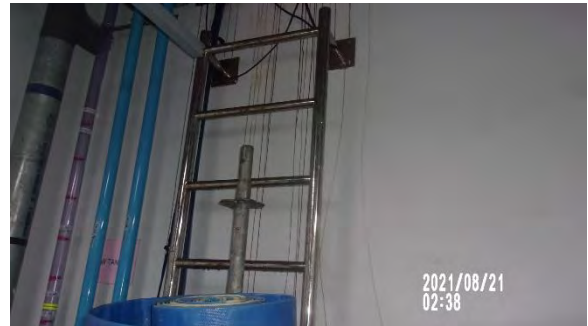
ภาพอุปกรณ์ภายในบ่อ CW Tank 1 สนิมขึ้นแต่ไม่มีการชำรุดเสียหาย ใช้งานได้ตามปกติ
