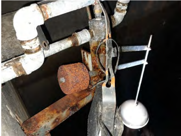
ภาพอุปกรณ์ภายในบ่อ CW Tank 2 สนิมขึ้นแต่ไม่มีการชำรุดเสียหาย ใช้งานได้ตามปกติ
