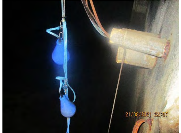
ภาพอุปกรณ์ภายในบ่อ CW Tank 2 สนิมขึ้นแต่ไม่มีการชำรุดเสียหาย ใช้งานได้ตามปกติ
