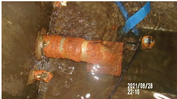
ภาพอุปกรณ์ภายในบ่อ CW Tank 4 สนิมขึ้นแต่ไม่มีการชำรุดเสียหาย ใช้งานได้ตามปกติ
