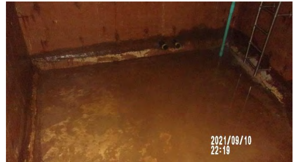
ภาพอุปกรณ์ภายในบ่อ Softener Tank ไม่มีการ ชำรุดเสียหาย ใช้งานได้ตามปกติ
