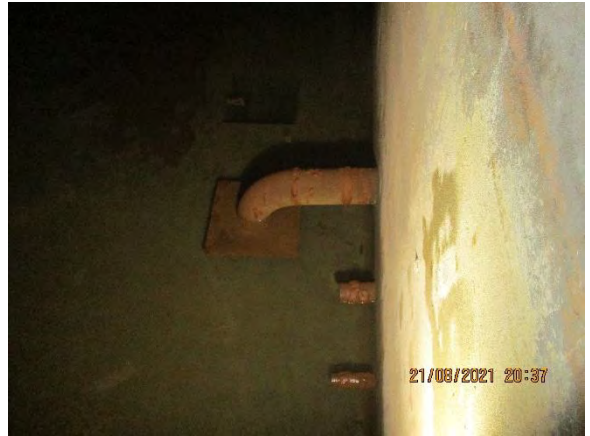
ภาพอุปกรณ์ภายในบ่อ Fire Tank 2 สนิมขึ้นแต่ไม่มีการชำรุดเสียหาย ใช้งานได้ตามปกติ
