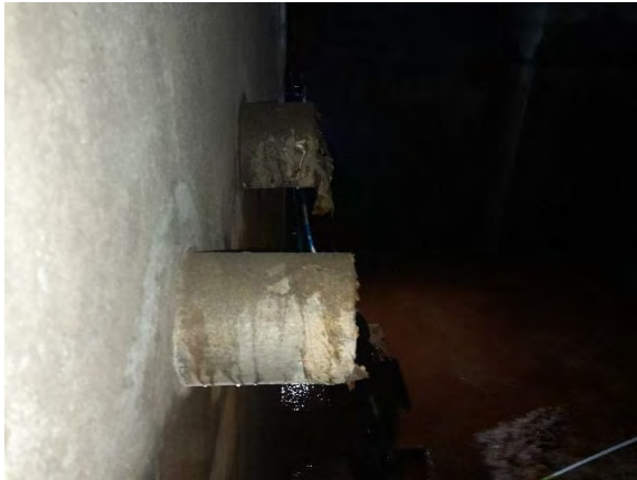
ภาพอุปกรณ์ภายในบ่อ Fire Tank 2 สนิมขึ้นแต่ไม่มีการชำรุดเสียหาย ใช้งานได้ตามปกติ
