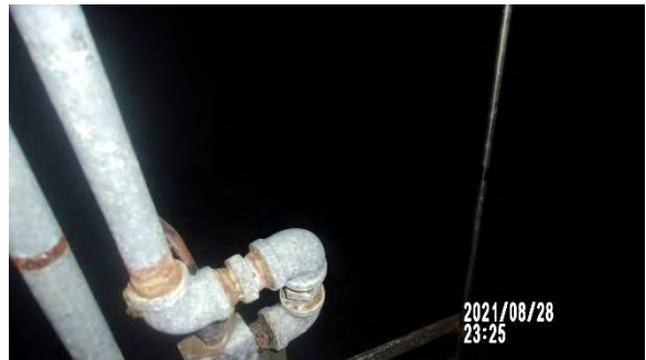
ภาพอุปกรณ์ภายในบ่อ CW Tank 4 สนิมขึ้นแต่ไม่มีการชำรุดเสียหาย ใช้งานได้ตามปกติ
