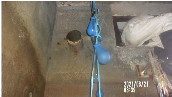
ภาพอุปกรณ์ภายในบ่อ CW Tank 1 สนิมขึ้นแต่ไม่มีการชำรุดเสียหาย ใช้งานได้ตามปกติ
